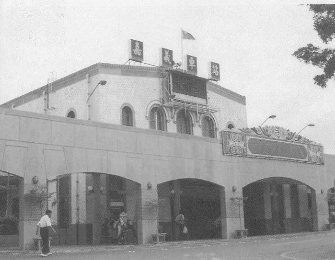
圖4 嘉義車站原本勻稱的建築結構，現在已被突兀的新建遮廊所破壞。
