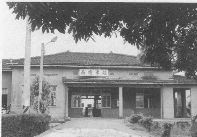
圖2 1943年戰爭中建造的南靖車站。
