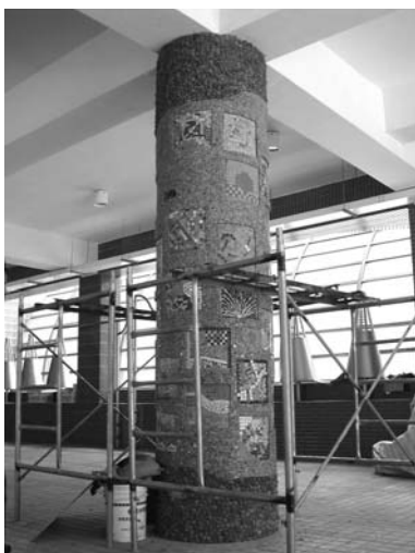
上牆施工鷹架
