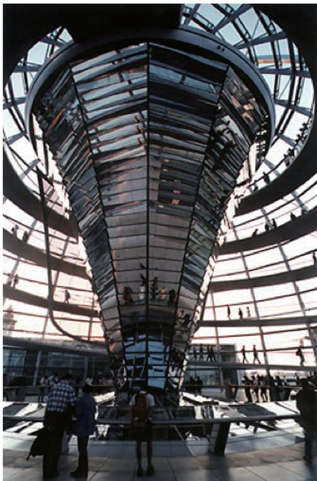
圖1-36 鋼構造半球體中的錐狀軸是一個少見的、高科技的建築創意，主司底下議會大廳的通風與採光。錐狀軸上一片片鏡面玻璃的角度，都是經過特別設計、調整過的，藉以將自然光導引到底下的議會大廳。
