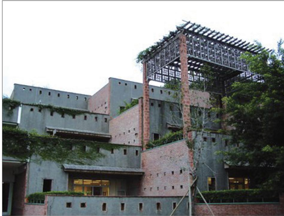
圖1-28 在南向的各式陽台與平台上，種植綠色爬藤，以免牆面受到太陽光的直接照射，而造成室內溫度的升高。這個簡單的作法，降低了外牆壁體的受熱量，也相對增加了室內環境的舒適度與協助節約能源目標的達成。
