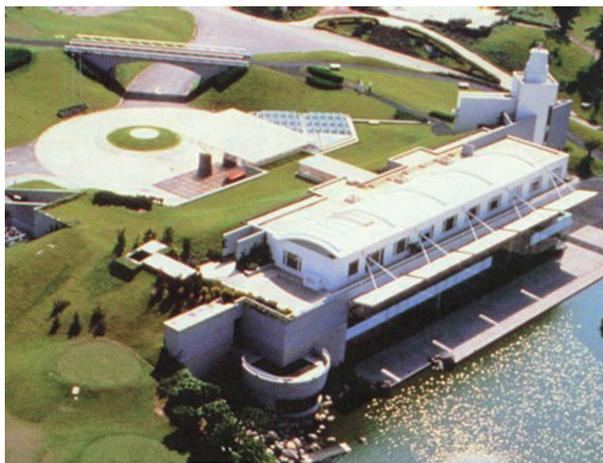
圖1-30 建築師在球場內挖掘了一個景觀水池，並將挖掘的廢棄土壤，化為球場內高低起伏的山坡地形之一，也形成了會館入口處覆土式建築的特徵。
