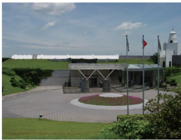
圖1-31 會館入口處除了輕盈的白色鋼構造頂遮與圓形花園外，全部覆蓋在土壤下，形成覆土式建築，好像整座會館建築都埋在土裡一般，建築物冬暖夏涼。
