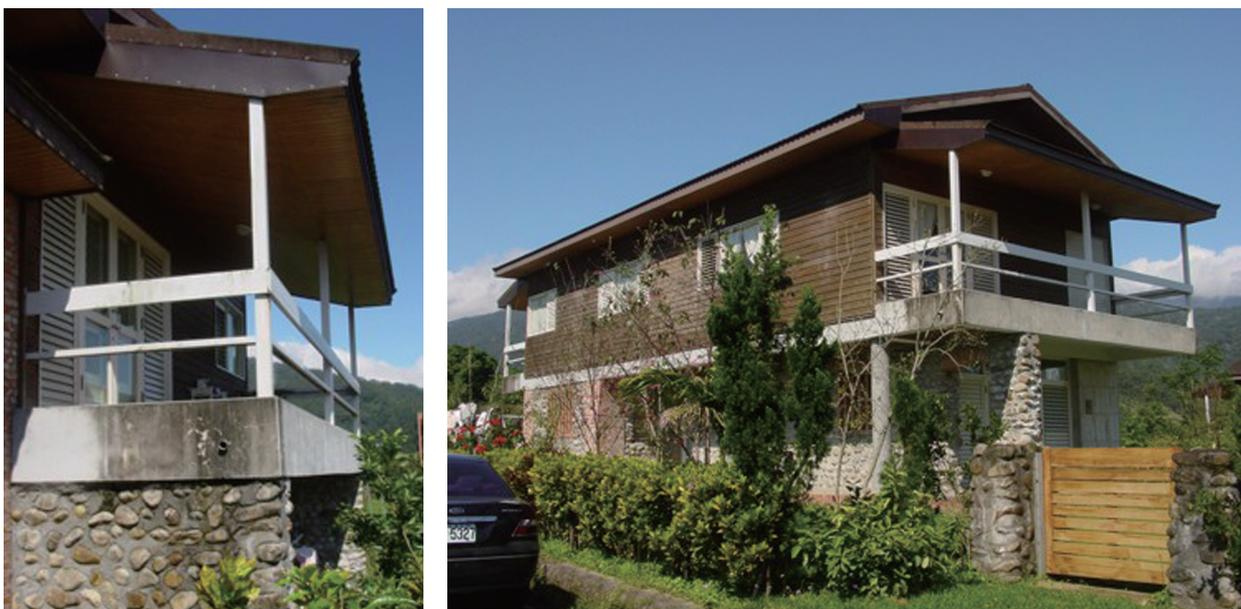
圖1-34、1-35 2號宜蘭厝的一樓採用磚石的承重牆構造，配合局部的板牆，並將部分的外牆向內退縮，使得開口較為自由，增加通風與抗震力。二樓採用輕鋼構，外側配有雨淋板，內側為石膏板，藉以降低造價。
