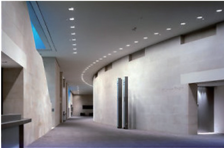
圖4-19 空間中洗牆照明
