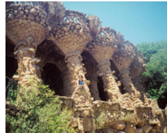
碎石高架走廊
