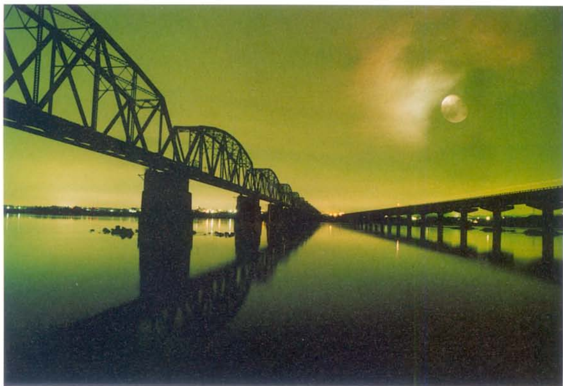
賴傳山 Lai, Chuan-Shan 鐵橋夜色
