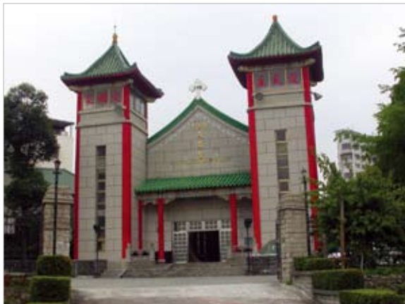
聖若望天主堂是一棟中西混合的教堂建築
