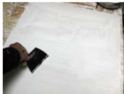
軟性刮刀輕輕地將油性打底劑刮平。
