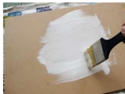
使用較寬的筆，沾著醇酸樹脂打底劑直接塗底。
