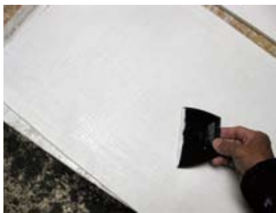
每次刷完打底劑，都要用軟性刮刀輕輕地將打底劑刮平。
