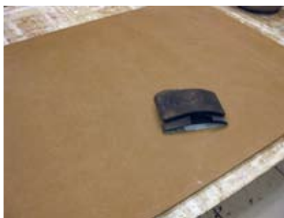
在刷第二層時，要等第一層乾了以後，用中目砂紙沿著板面以回旋方向小心的打磨。
