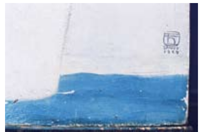
顏料層過厚形成龜裂剝落。
