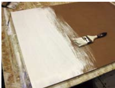
刷底劑：一般打底劑至少刷三層。
