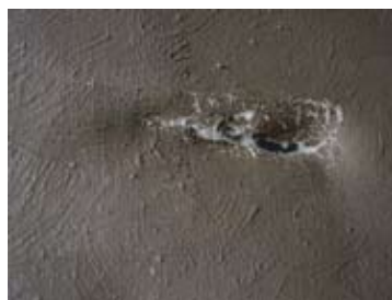
一點集中形成外在壓力所形成的龜裂。
