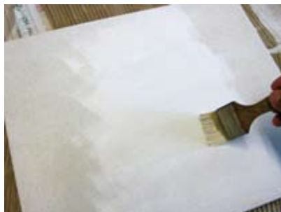
第二層使用相反方向塗刷。
