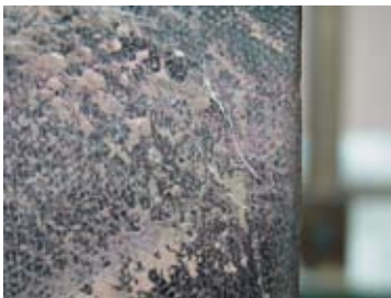
內框邊緣的放射型龜裂。
