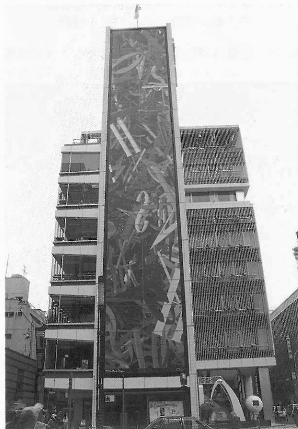
圖 21. 日本新力大樓採用電腦繪圖的建築立面
