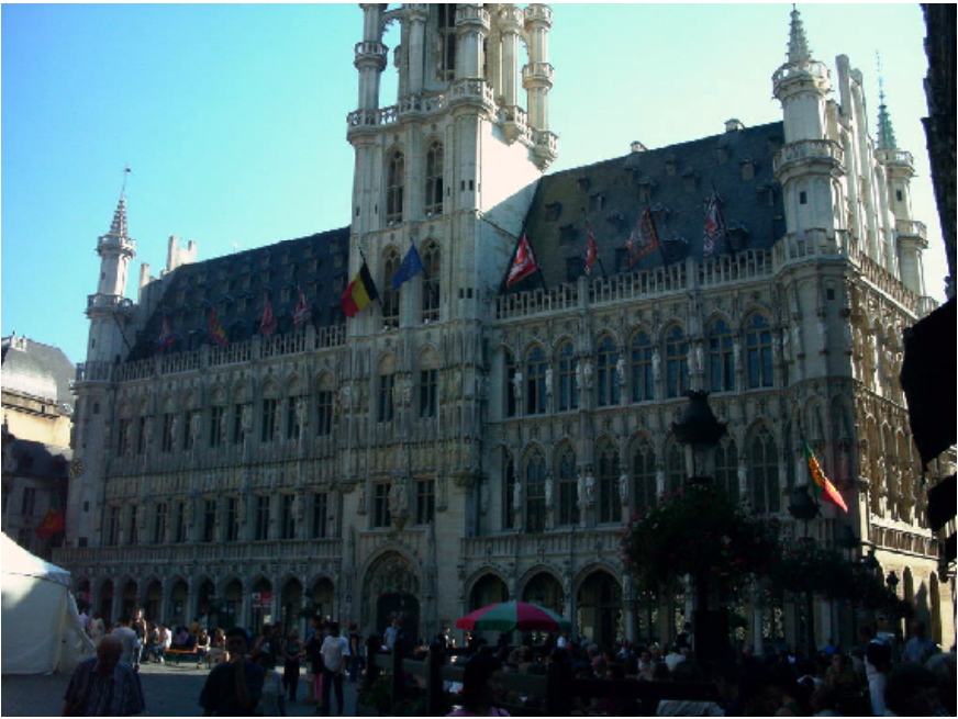
圖 3.2.1.14 比利時布魯塞爾市政廳，為一精工精細的哥德式建築。但尖塔左右樓寬不對稱（數一下開口數即可發現），減損了形式審美價值（Photo: Hsiao）。
