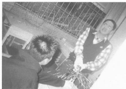
(3-3) 以點焊機點焊交點處
