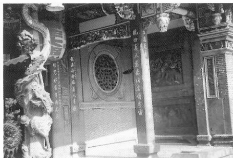
2-8 保安宮三川殿，龍邊，龍柱
