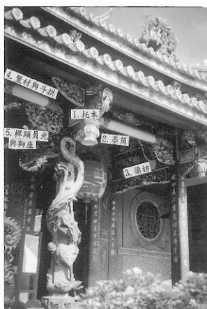
2-1 保安宮 1. 托木 2. 吊筒 3. 梁枋 4. 豎材與斗拱 5. 樞頭員光與獅座
