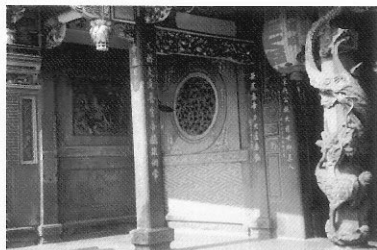
3-3 台北市保安宮虎邊之建構有 A. 虎門樨頭 B. 白虎石雕牆 C. 窗雕 D. 對聯 E. 吊筒 F. 梁枋 G. 龍柱
