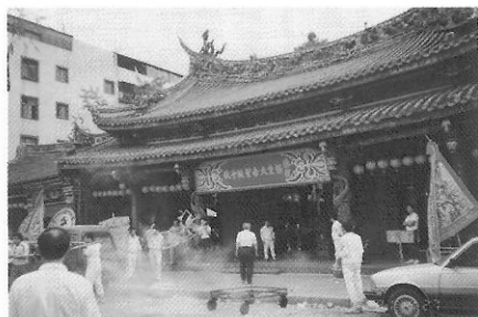
1-1 台北市大龍峒保安宮，保生大帝聖誕千秋前景，屋頂燕尾脊，脊上雙龍戲珠，水浪，以防火災。
