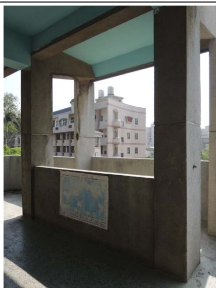
D 三樓走廊 第( 4 )組
