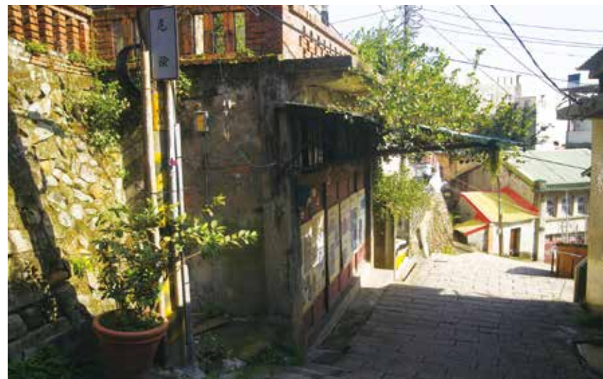
重建街16號街屋與14號街屋為鄰，依地形地勢起築，為當地街屋的建築典範。
