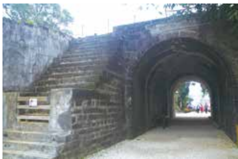
滬尾礮臺仍保留礮臺旁兩道城牆及數座砲臺。
