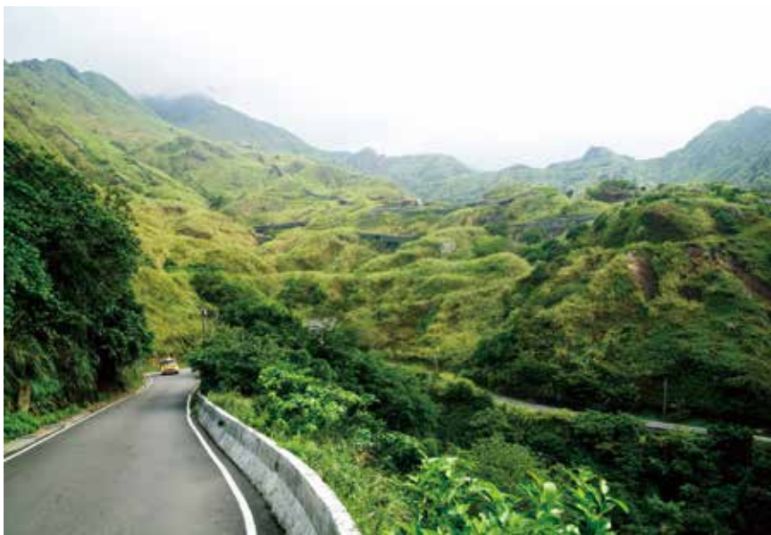
臺金濂洞煉銅廠煙道沿山坡而上，煙道整體構造保存完整，見證臺灣的礦業發展史。
