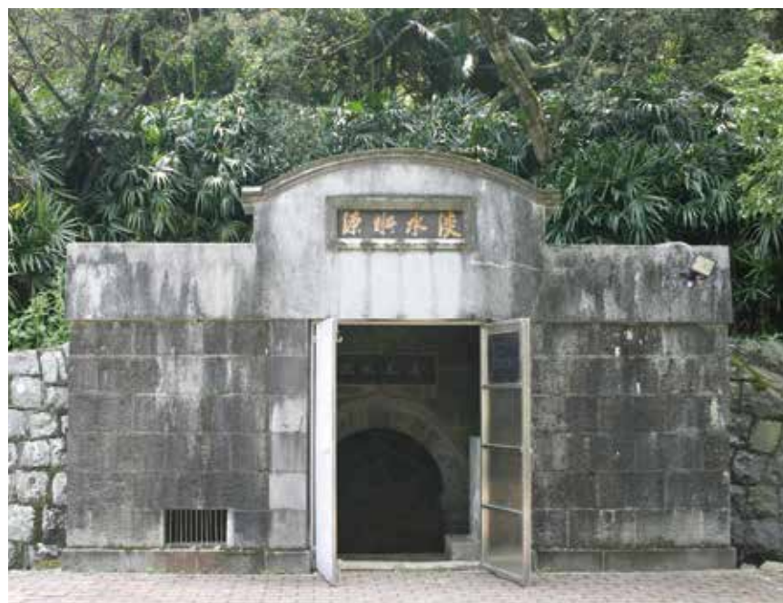
滬尾水道石室外牆門匾題有「淡水水源」字樣。
