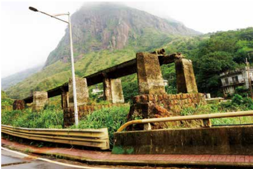
煙管主要為過去煉銅廠排放煉銅廢煙至後山無人居住之處，高約2公尺寬1.5公尺，因臺金公司停產而廢棄。
