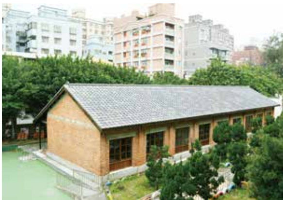
八里國民小學紅磚教室為八里區現存較為古老的教室建築。
