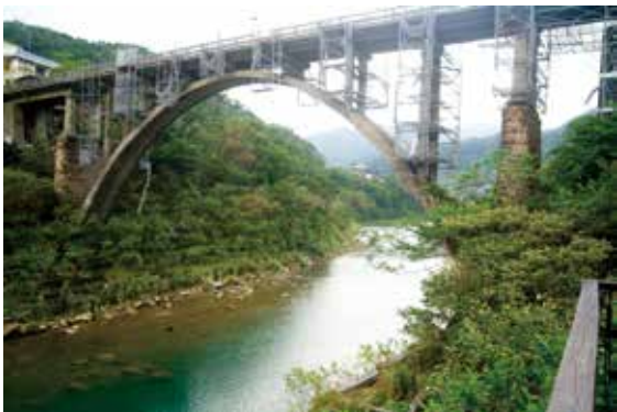
這座「瑞三大橋」高空運煤橋又稱「三層鐵橋」，和選煤廠連接。
