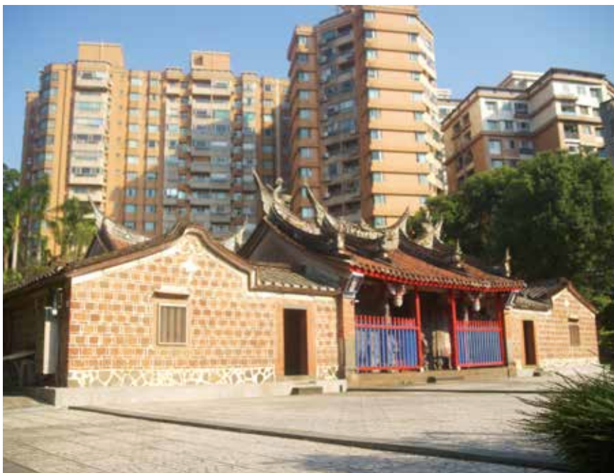
淡水鄞山寺鄰近捷運淡水站，靜謐地座落於住宅區之中。
