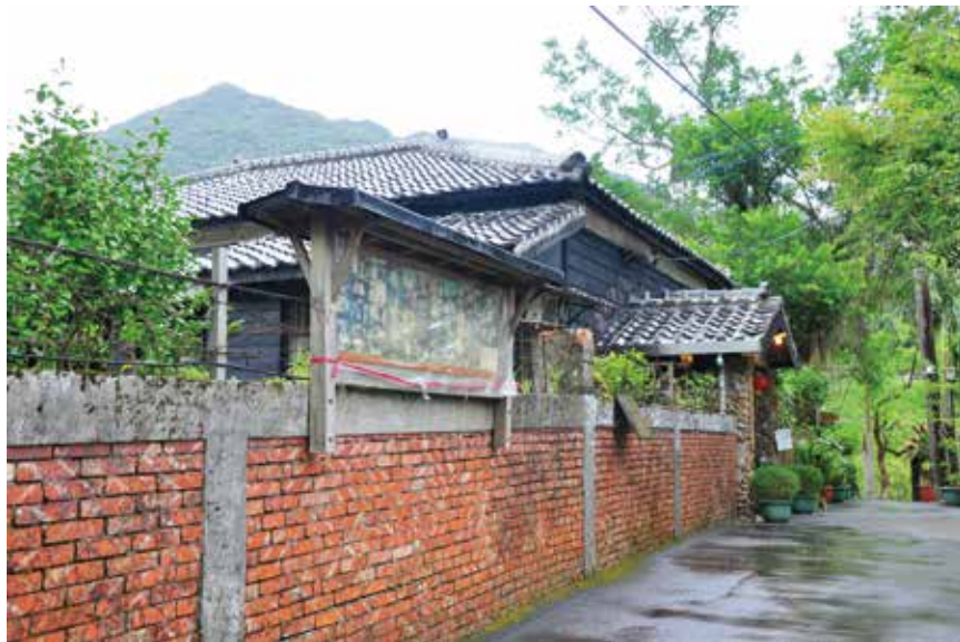
具有黑瓦屋頂的宿舍建築及紅磚圍牆。
