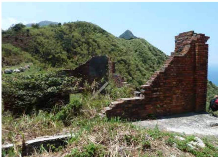
水湳洞本山六坑口及索道系統為金瓜石礦業設施裡重要的運送要道。
