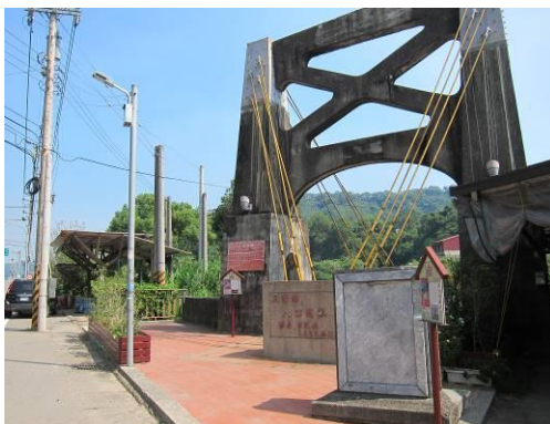
圖 24：月眉橋南岸橋墩 ( 2017 )
