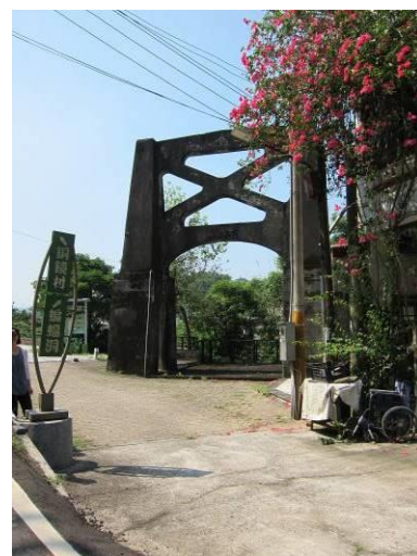
圖 25：月眉橋北岸橋墩 ( 2017 )
