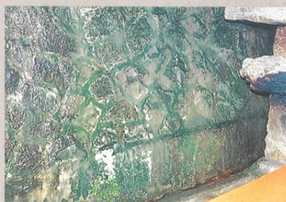
圖十三 石窟右側之山壁，有約二公尺高的護坡牆。
