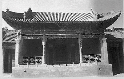
圖五十 明代改革性戲臺——埋置音缸及青石鏤空音穴擴聲（山西翼城縣樊店村關帝廟戲臺）
