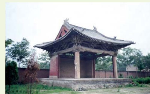
圖3-2 山西臨汾市魏村牛王廟元代戲台（1283年建、現存最古的戲台）
