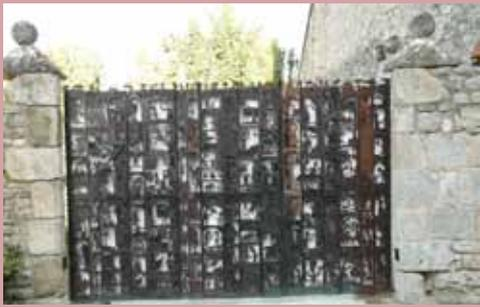
4-2 以鏤空的鐵片切割成剪影圖樣，再焊接成集錦式的大門。
