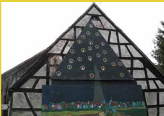
7 一幅木板壁畫把舊房變成了童話之屋。
