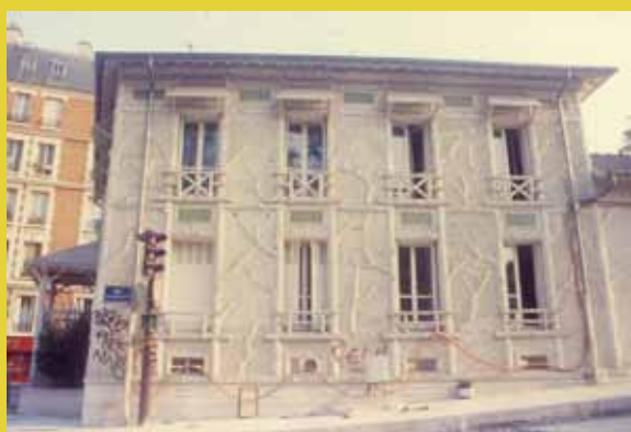
5 藉由水泥塑造，整棟房子宛如樹屋。
