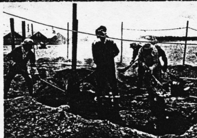
稻殼堆整體燒成灰燼後，進行取出作業
