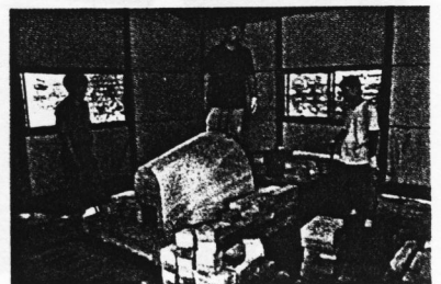
圖五：燃燒室拱形板架架架構築情形。
